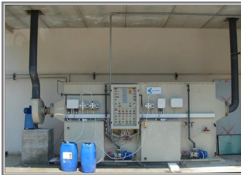
Fig. 1 e 2: Esempi di scrubber orizzontali a doppio stadio di lavaggio.
