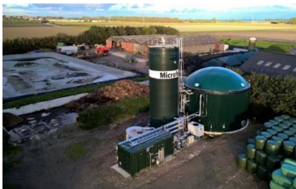
Installazione Bright Biomethane di Den Bommel (40 Nm 3 /h)
